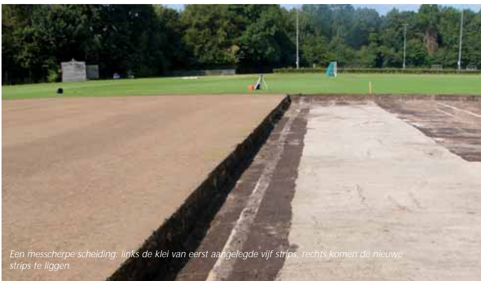
Het kneden en vlak maken van de zware zavel. Deze ligt op een zandbed.
