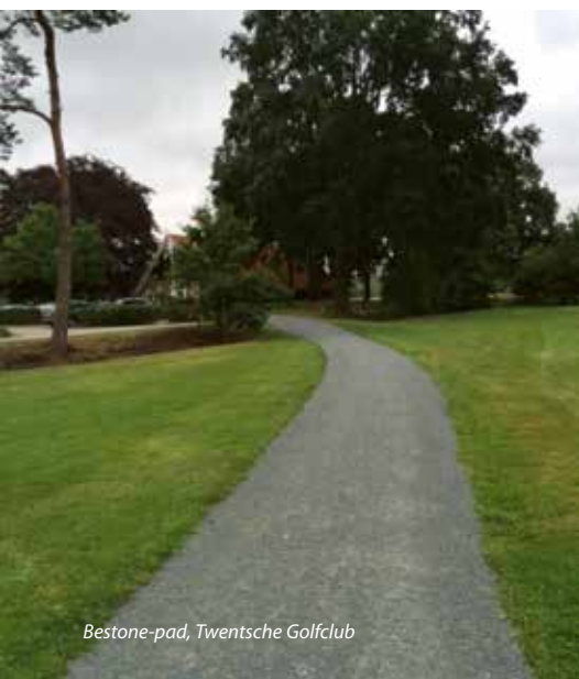
Aanleg van Bestone: begin met een goed fundament en meng de Bestone goed alvorens het aan te brengen en te profileren.
